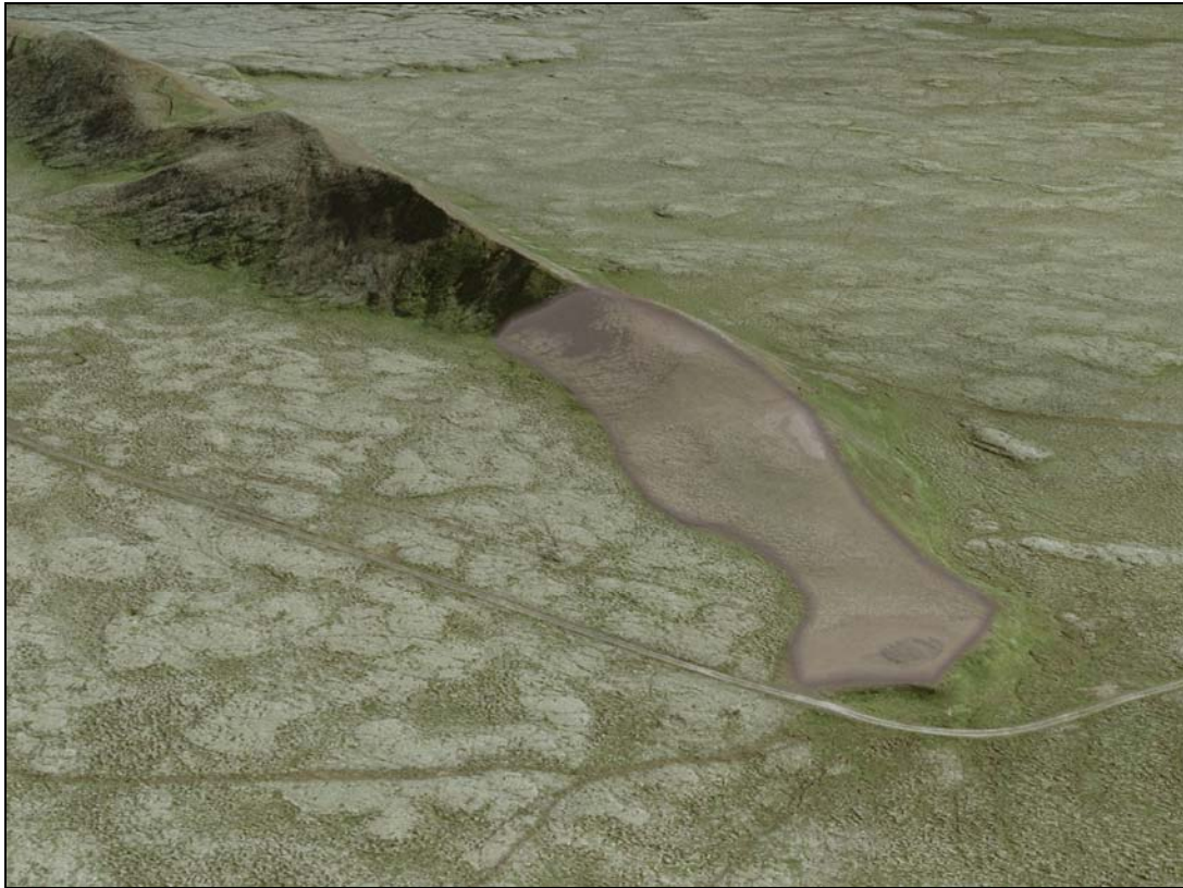
Mynd 6.1 Náma A í suðurenda Litla-Reyðarbarmur, horft til norðausturs. Skyggði hlutinn sýnir væntanlegt efnistökusvæði.
